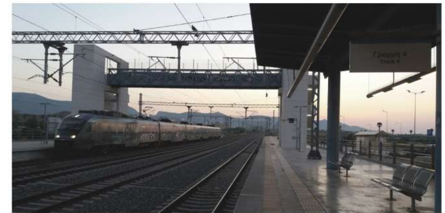
>ΕΙΚΟΝΑ_7: ΣΤΑΘΜΟΣ ΠΡΟΑΣΤΙΑΚΟΥ ΜΕΓΑΡΩΝ
