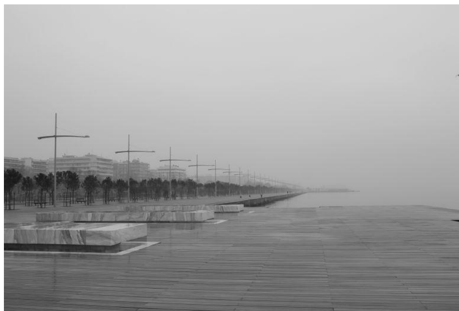
Εικόνα 3. Αποψη του κρηπιδώματος της Νέας παραλίας Θεσσαλονίκης. (Πηγή: https://www.nikiforidis-cuomo.com/work/urban-design/3#intro )
