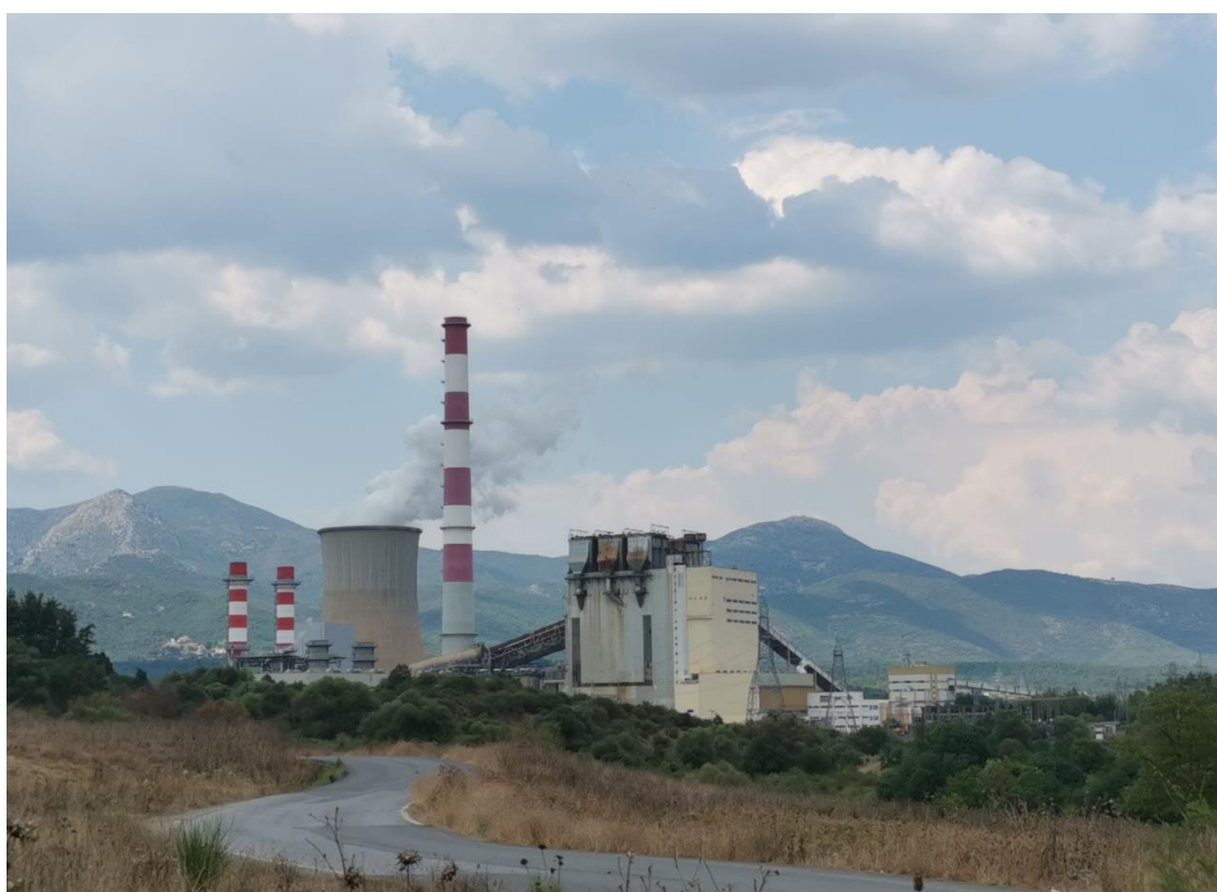
Εικόνα 2.2: Άποψη ατμοηλεκτρικού εργοστασίου Μεγαλόπολης
