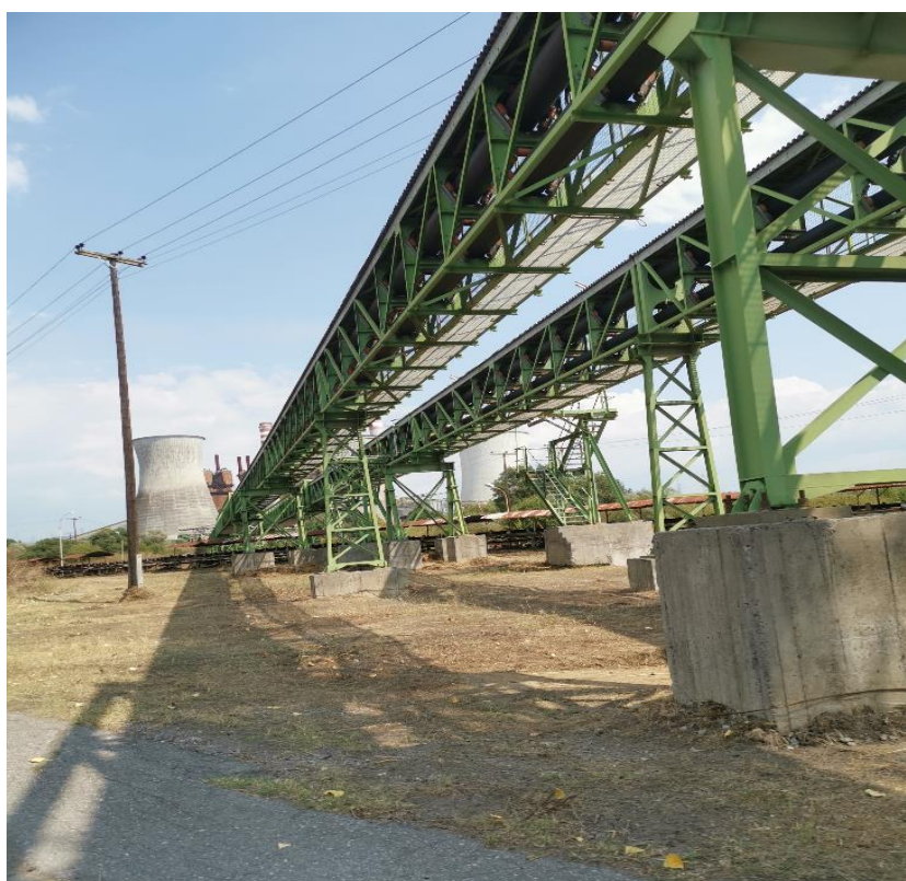
Εικόνα 1.1: Ταινιόδρομος ατμοηλεκτρικού σταθμού της Μεγαλόπολης
