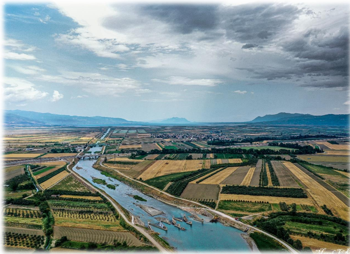
Εικόνα 5.20 Τάφρος Λαμίας και Φράγμα διευθέτησης υδάτων - Μεριστής, (Φωτ Κ. Μεράκος Βάνιας 2021).
