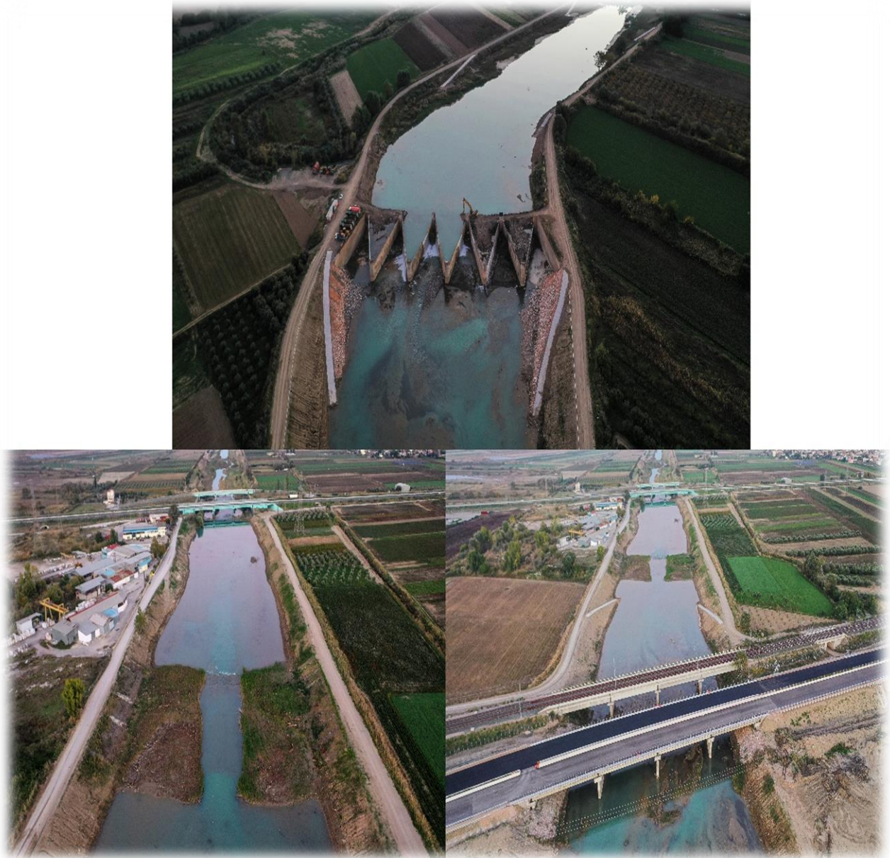
Εικόνα 2.12. Έργα πριν τις εκβολές Σπερχειού, στην τάφρο Λαμίας και αντιπλημμυρικό φράγμα - Μεριστής (Φωτ. Κ. Μεράκος Βάνιας 2021)
