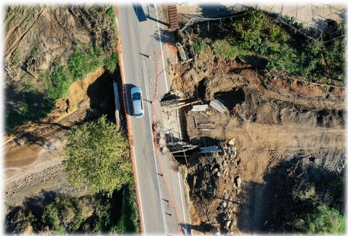
Εικόνα 2.9 Πτώση Δρόμου Λαμίας – Καρπενησίου, μετά από ακραία καιρικά φαινόμενα (Ιανός 2020) στην περιοχή Παλιούρι παράλληλα του Σπερχείου ποταμού. (Φωτ Κ. Μεράκος Βάνιας 2020)
