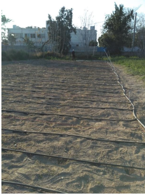
Εικόνα 8. Εγκατάσταση του αρδευτικού συστήματος
