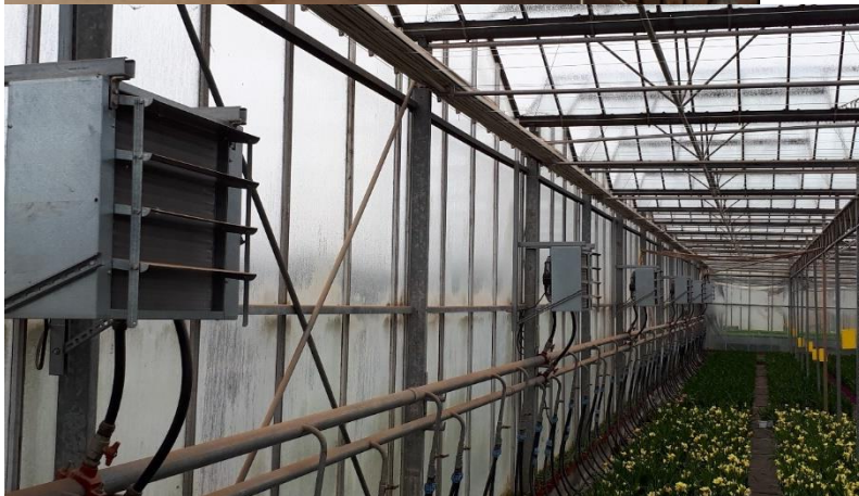
Εικόνα 7.9 Τερματικές μονάδες fan-coil που χρησιμοποιούνται για τη θέρμανση του θερμοκηπίου (πηγή: Φυτώρια Ανδρή).
