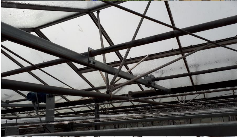
Εικόνα 7.6 Κινητήρας και μηχανισμός μετάδοσης κίνησης για το άνοιγμα και το κλείσιμο των παραθύρων. (πηγή: Φυτώρια Ανδρή).
