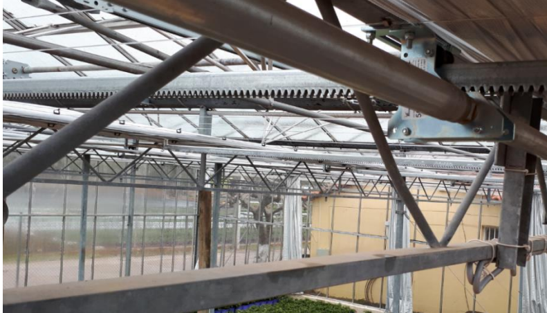
Εικόνα 7.5 Κινητήρας και μηχανισμός μετάδοσης κίνησης για το άνοιγμα και το κλείσιμο της θερμοκουρτίνας. (πηγή: Φυτώρια Ανδρή).
