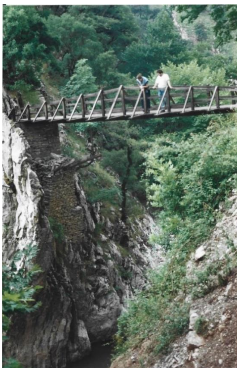
Εικόνα 5.46 Η αφετηρία του μονοπατιού και η πεζογέφυρα (φωτο: Γκορόγιας Ν.)
