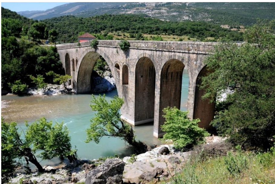
Εικόνα 4.4 Γέφυρα Αυλακίου (πηγή: https://karvasaras.gr/wp-content/uploads/2020/05/gefyra-avlakiou-axeloos-1-1024x680.jpg )
