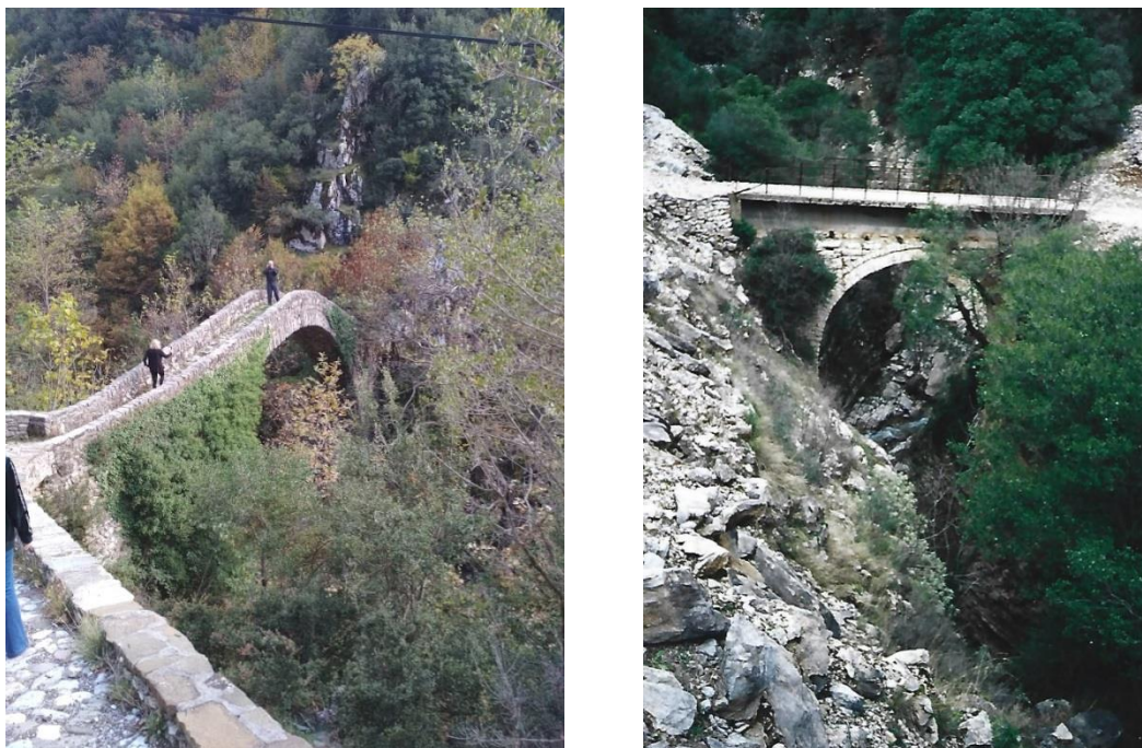
Εικόνα 4.6 & 4.7 Γεφύρι Αγράφων & ψηλό γεφύρι Μοναστηρακίου (φωτο: Γκορόγιας Ν.)
