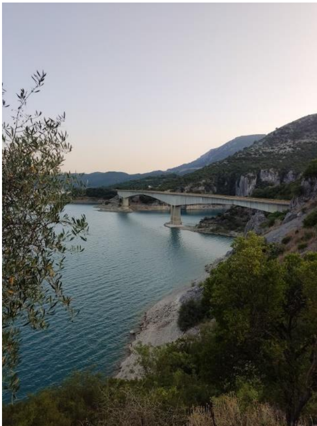
Εικόνα 4.9 Γέφυρα Τατάρνας (φωτο: Γκορόγιας Ν.)
