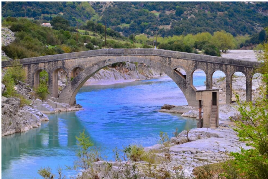
Εικόνα 4.3 Γέφυρα Τέμπλας (φωτο: Μπουμπουρής Ι.)
