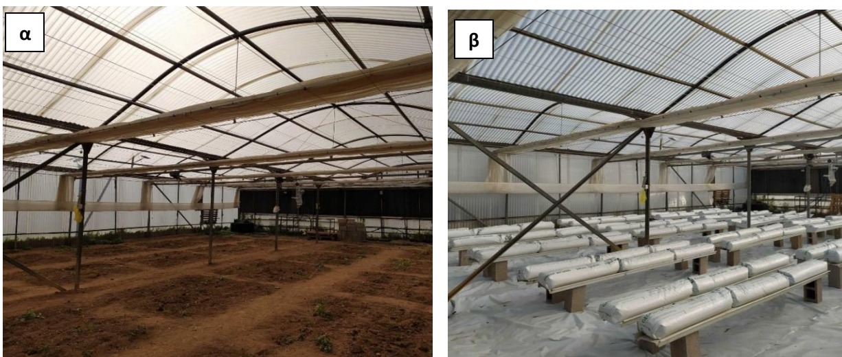
Εικόνα 14: α) Απομάκρυνση ζιζανίων από το έδαφος του θερμοκηπίου. β) Στρώσιμο πλαστικού στο έδαφος, τοποθέτηση των καναλιών και των σάκων περλίτη.
