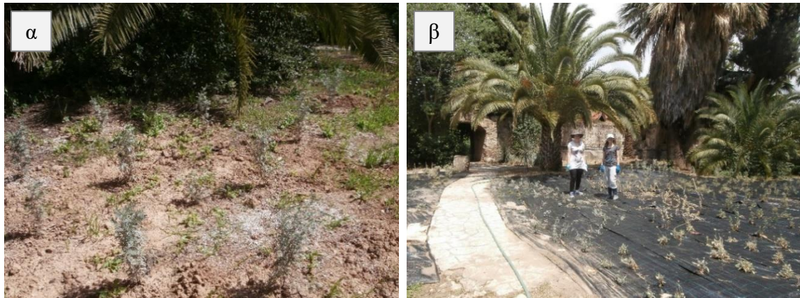
Εικόνα III.9. Τοποθέτηση γεωφάσματος και φύτευση (α και β), στο Βοτανικό Κήπο του Εργαστηρίου Ανθοκομίας και Αρχιτεκτονικής Τοπίου του Γ.Π.Α. (Λήψη φωτογραφιών: Απρίλιος 2015).
