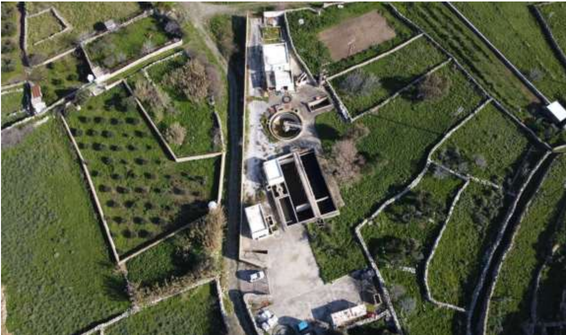
Εικόνα 5.9 Άποψη των εγκαταστάσεων της μονάδας του βιολογικού καθαρισμού του Πανόρμου
