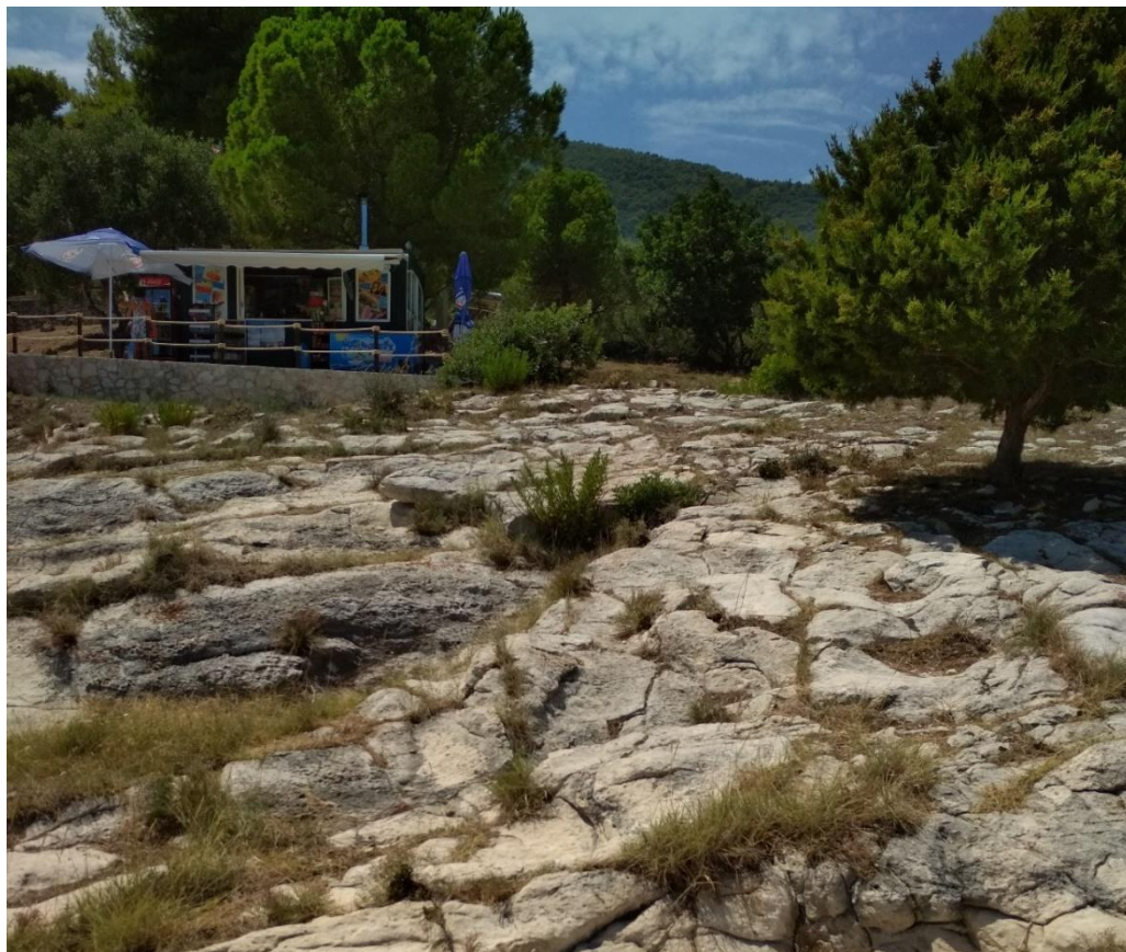
Εικόνα 3.4.14. Κατασκευή καντίνας στην περιοχή Μαραθίας.
