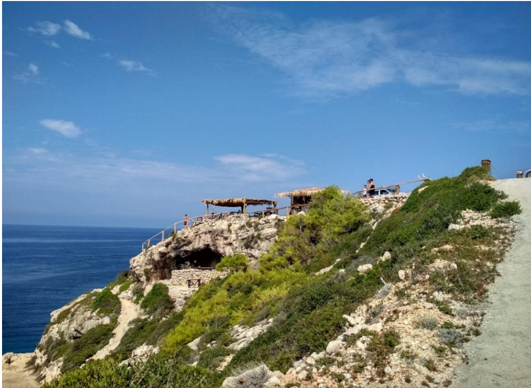
Εικόνα 3.4.13. Κατασκευή δρόμου και καντίνας στην περιοχή Κορακονήσι.
