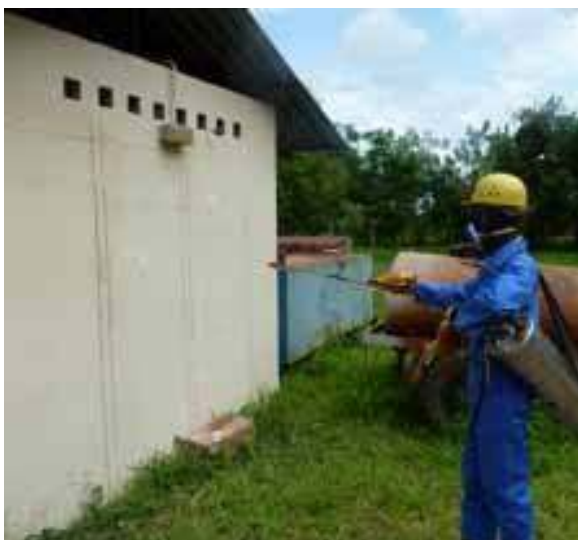
Εικόνα 1.20: Υπολειμματικός ψεκασμός σε εξωτερικό χώρο
