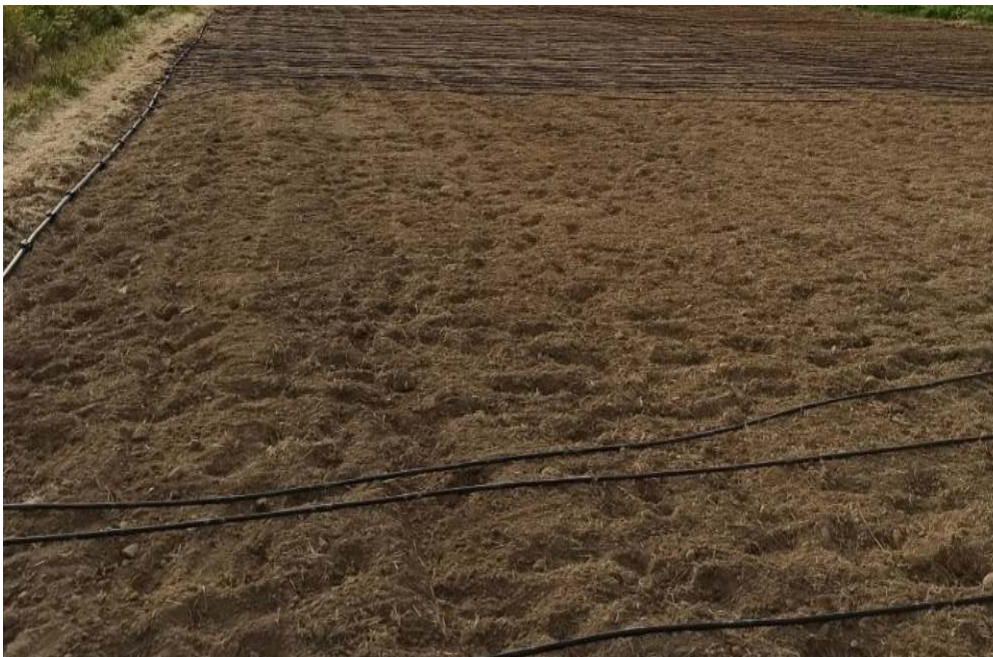
Εικόνα 3.2: Εγκατάσταση σωλήνων άρδευσης διαμέτρου φ16 κατά μήκος του πειραματικού αγρού.
