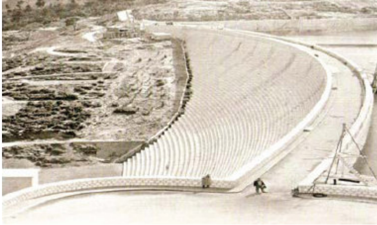
Εικόνα 12: Κατασκευή φράγματος Μαραθώνα σε τελικό στάδιο (φωτό 1930) [3]
