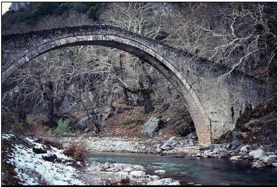
Εικόνα Δ.28: Το τοξωτό γεφύρι στην Πύλη (218m) Τρικάλων. Πηγή: Ευγενική παραχώρηση φωτογραφίας από τον Ιωάννη Θ.Καραγεώργο.
