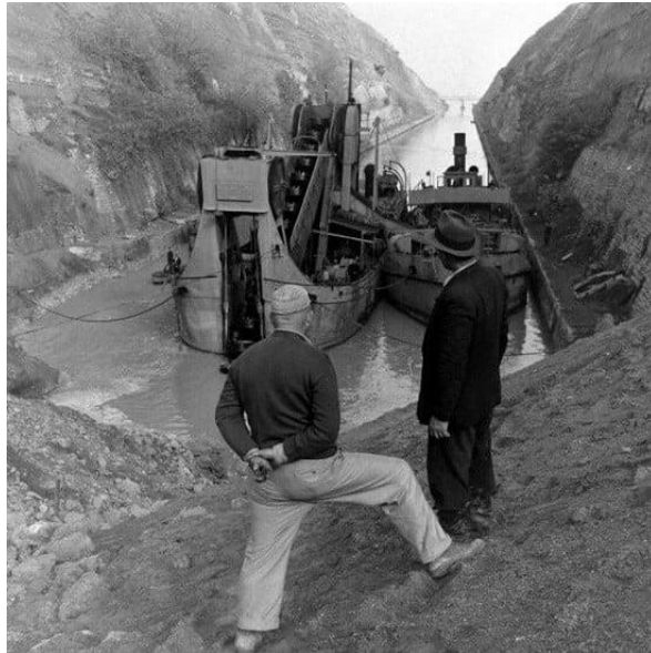
Εικόνα 16 Εργασίες εκσκαφών της Διώρυγας της Κορίνθου.
