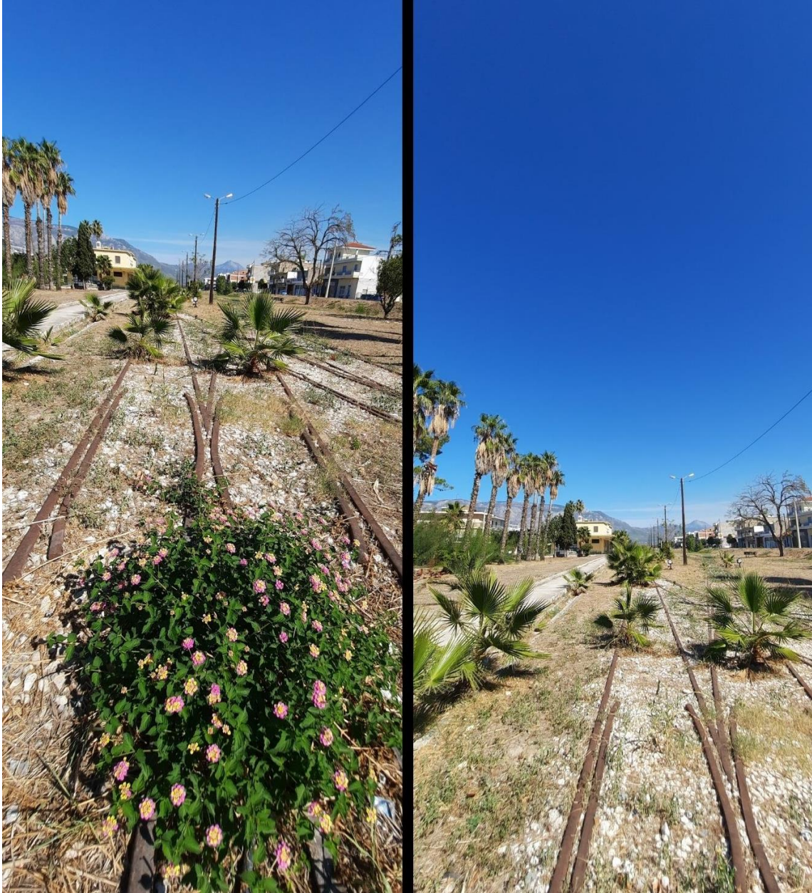
Εικόνα 40 Περιοχή μελέτης - Υφιστάμενη κατάσταση.
