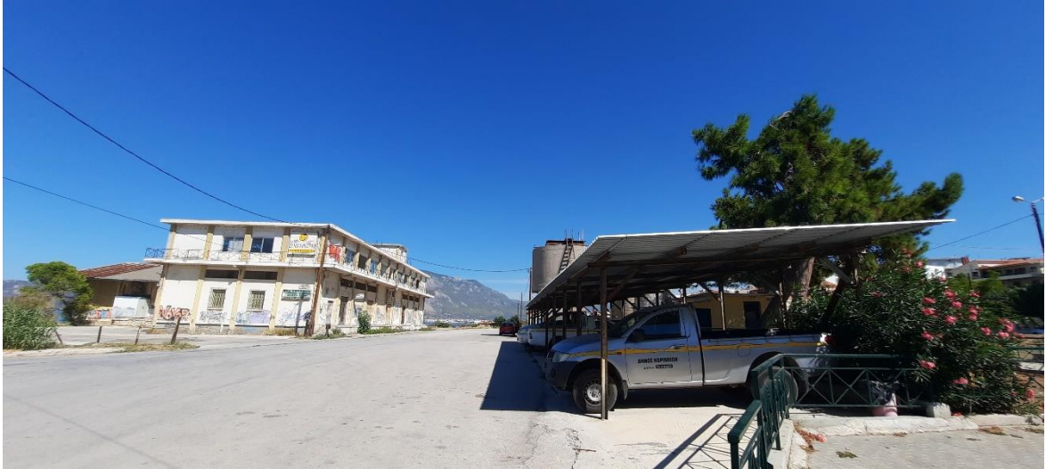
Εικόνα 41 Περιοχή μελέτης - Υφιστάμενη κατάσταση.
