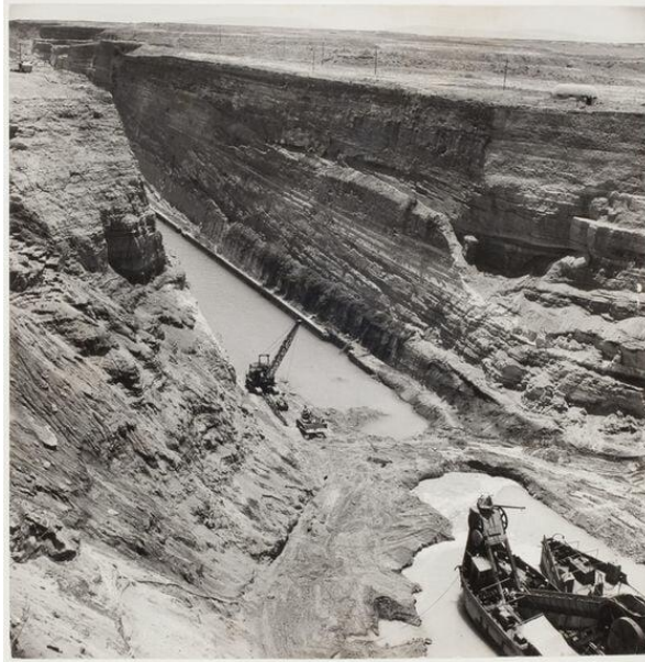
Εικόνα 15 Εργασίες εκσκαφών της Διώρυγας της Κορίνθου.
