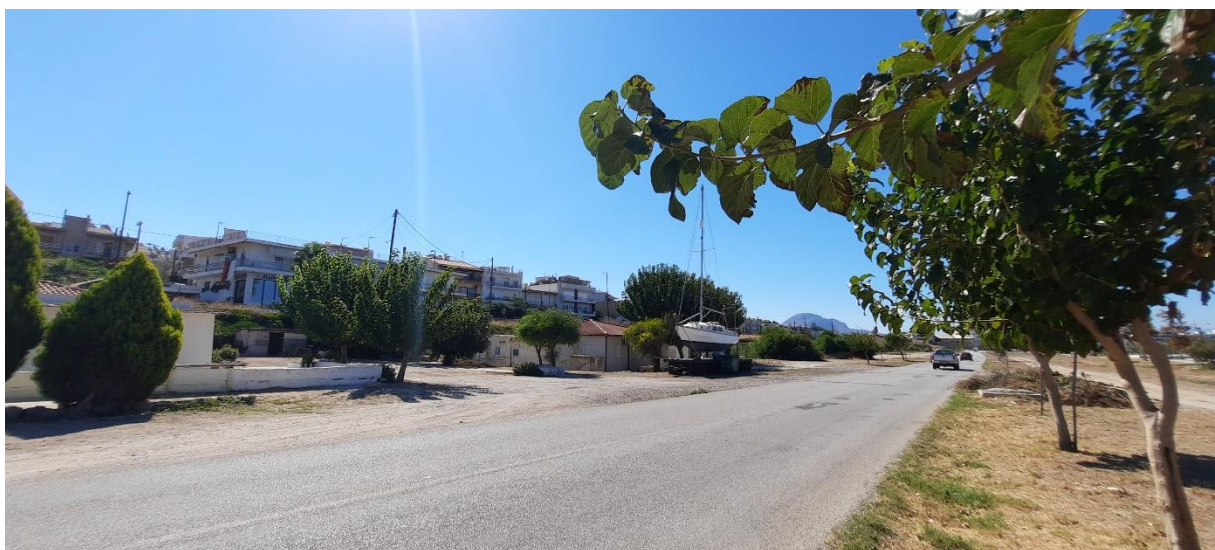
Εικόνα 32 Περιοχή μελέτης - Υφιστάμενη κατάσταση.
