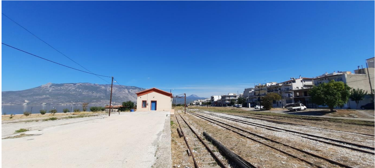
Εικόνα 44 Περιοχή μελέτης - Υφιστάμενη κατάσταση.
