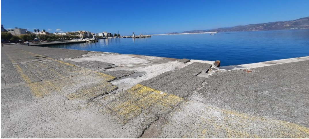
Εικόνα 53 Περιοχή μελέτης - Υφιστάμενη κατάσταση.
