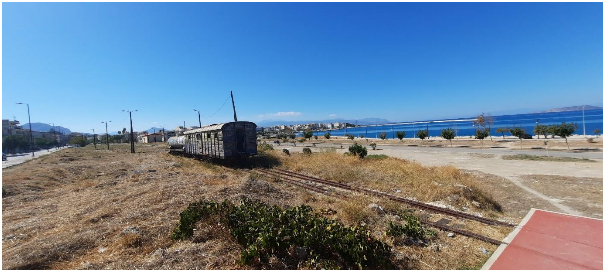
Εικόνα 45 Περιοχή μελέτης - Υφιστάμενη κατάσταση.
