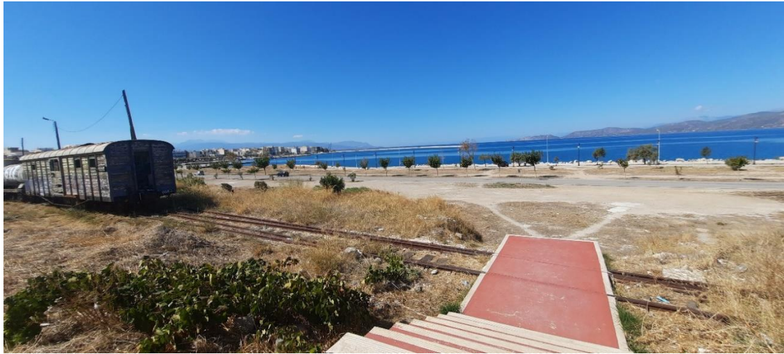
Εικόνα 26 Περιοχή μελέτης - Υφιστάμενη κατάσταση.
