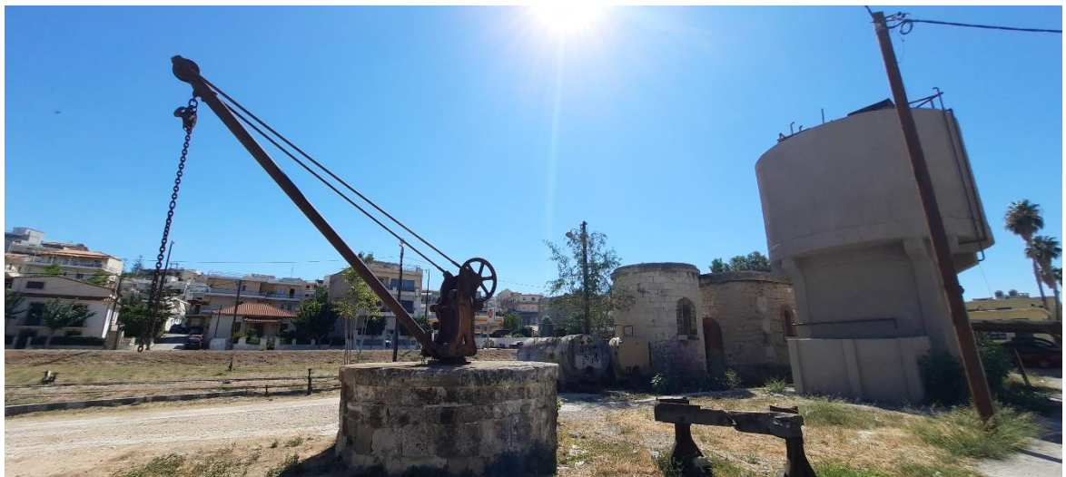
Εικόνα 43 Περιοχή μελέτης - Υφιστάμενη κατάσταση.
