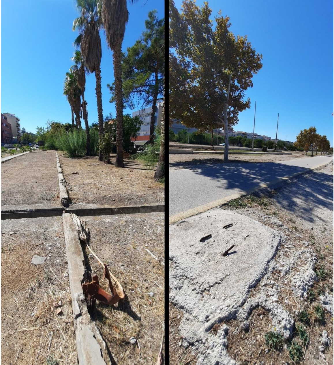
Εικόνα 50 Περιοχή μελέτης - Υφιστάμενη κατάσταση.
