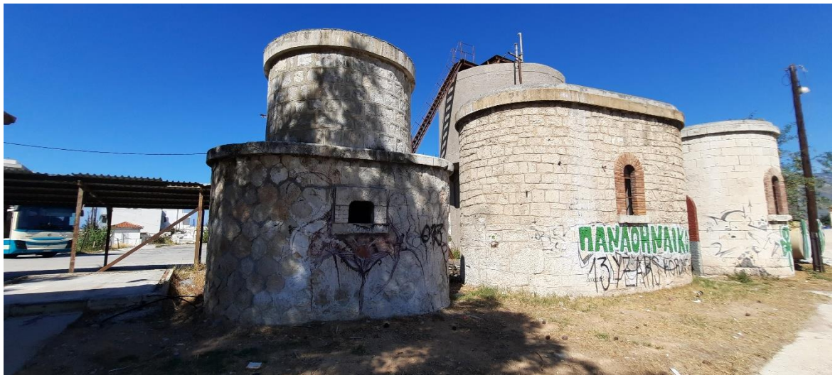
Εικόνα 42 Περιοχή μελέτης - Υφιστάμενη κατάσταση.
