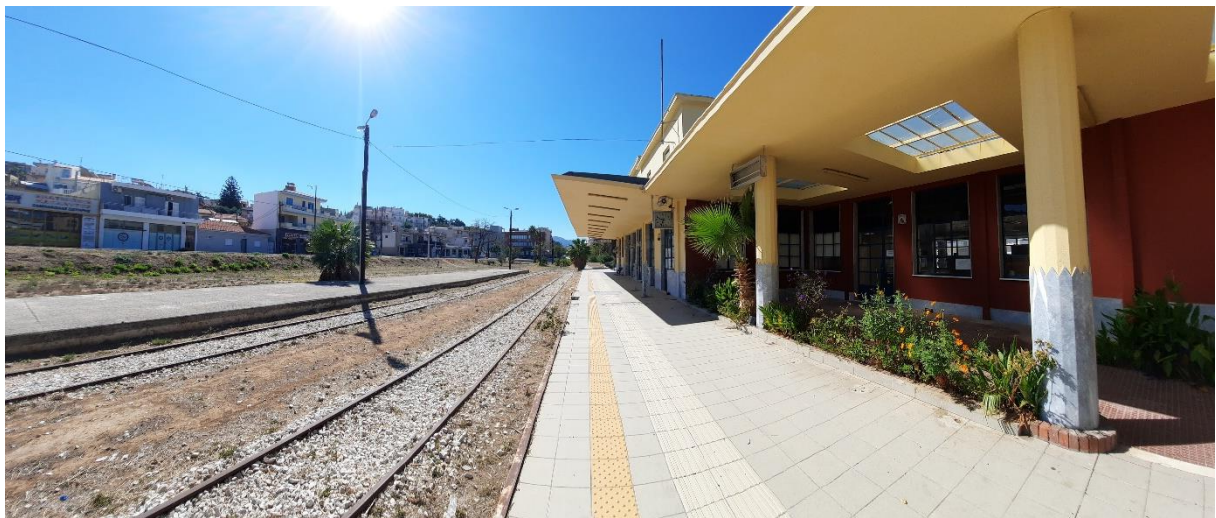
Εικόνα 36 Περιοχή μελέτης - Υφιστάμενη κατάσταση.
