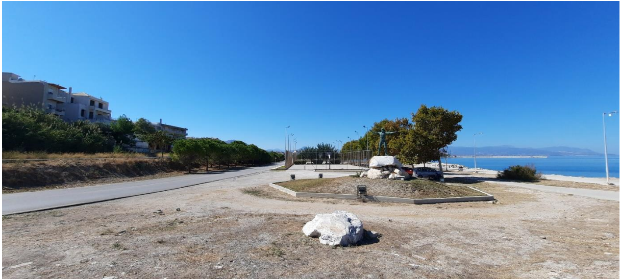
Εικόνα 29 Περιοχή μελέτης - Υφιστάμενη κατάσταση.
