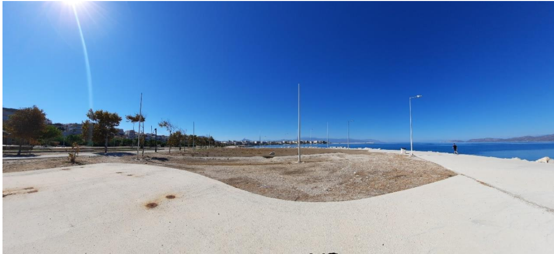
Εικόνα 33 Περιοχή μελέτης - Υφιστάμενη κατάσταση.
