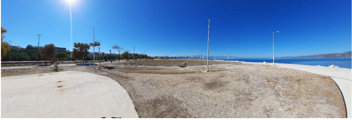
Εικόνα 51 Περιοχή μελέτης - Υφιστάμενη κατάσταση.
