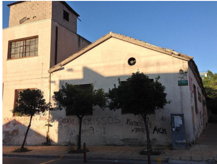
Εικόνα 44 Το εγκαταλελειμμένο κτήριο της εριουργίας σήμερα.
