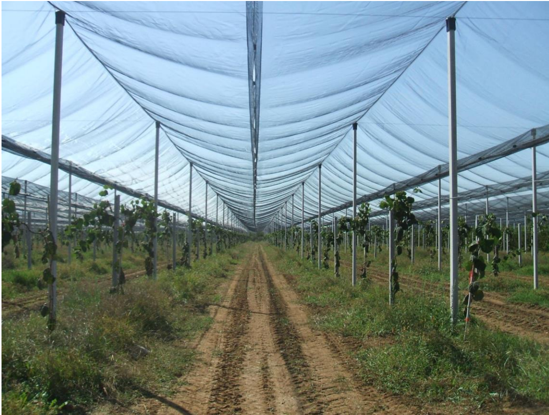
Εικόνα 14: Κατασκευή αντιχαλαζικών δικτυών Πηγή : ΕΛΓΑ
