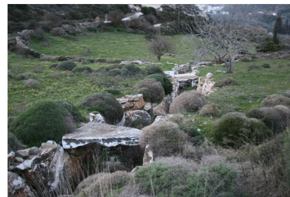
Εικόνα 10 Ξερολιθιάς στον κινίδαρο για τη διαχείριση ομβρίων πηγή: προσωπικό αρχείο
