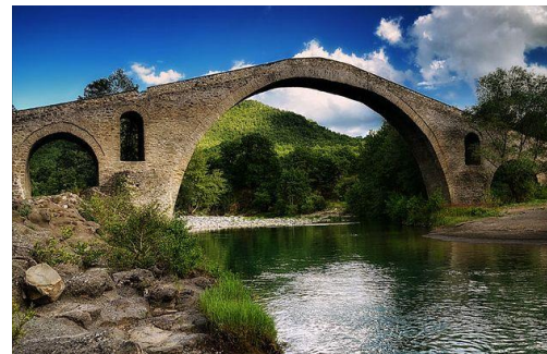
Εικόνα 45. Το γεφύρι του Αζίζ Αγά Πηγή: (Visit-Grevena.gr 2022)
