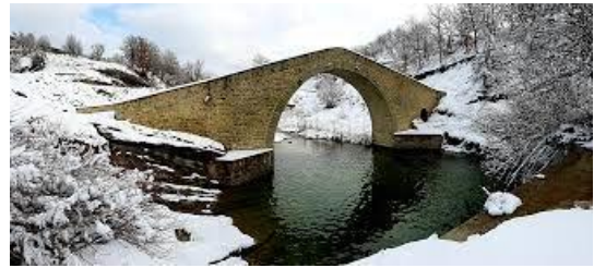
Εικόνα 40. Το Γεφύρι του Παλιομάγερου Πηγή: (Visit-Grevena.gr 2022)
