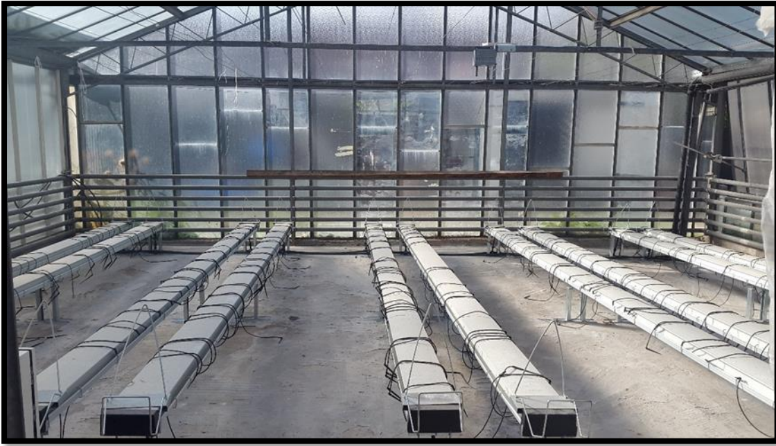
Εικόνα 2-1. Θάλαμος του ναλόφρακτου θερμοκηπίου όπου είναι εγκατεστημένα τα εναέρια κανάλια υδροπονίας.
