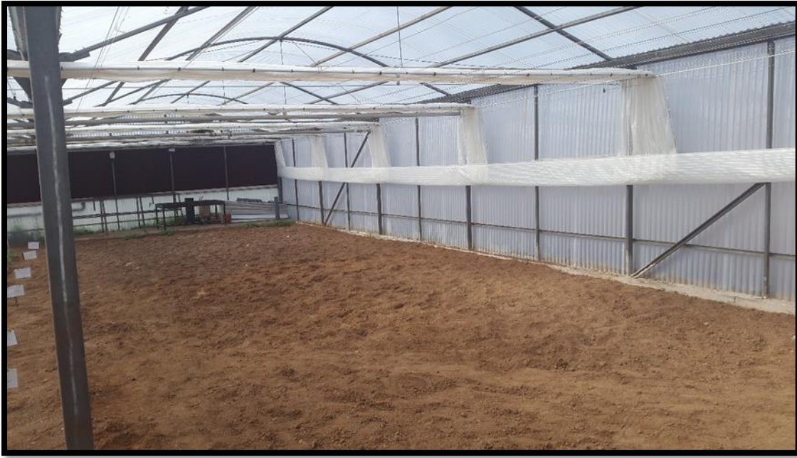
Εικόνα 2-2. Εσωτερικό του πλαστικού θερμοκηπίου όπου διακρίνονται το ενεργητικό σύστημα σκίασης με κουρτίνες και το σύστημα της υγρής παρείας.
