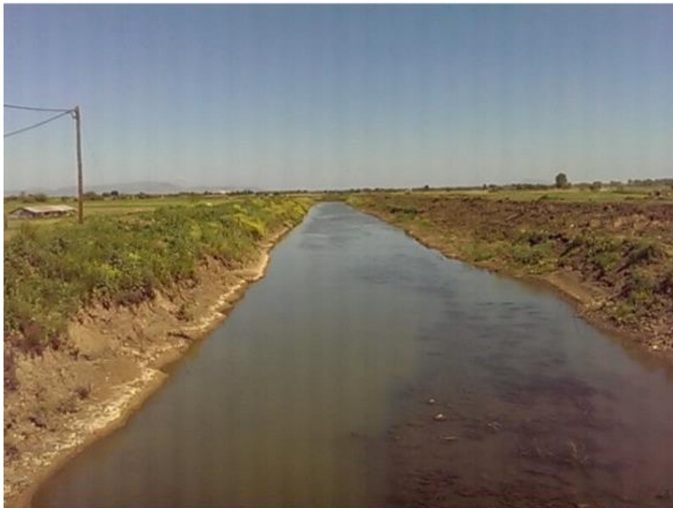
Εικόνα 2-16: Ο παραπόταμος Μέγας στην περιοχή των Καρδιτσομάγουλων, στη Θεσσαλία. Διακρίνονται οι εργασίες καθαρισμού της κοίτης (Υπουργείο Περιβάλλοντος, Ενέργειας και Κλιματικής Αλλαγής, 2018, Φωτογραφικό υλικό)
