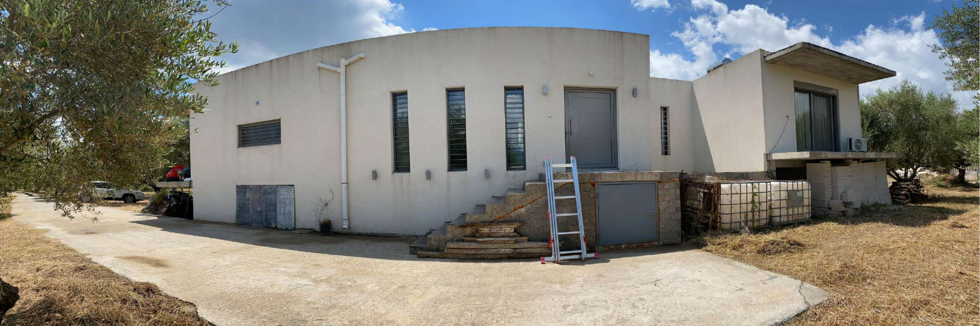
Εικόνα 45. Υπάρχον κτίσμα άποψη Α' (πηγή: προσωπικό αρχείο)
