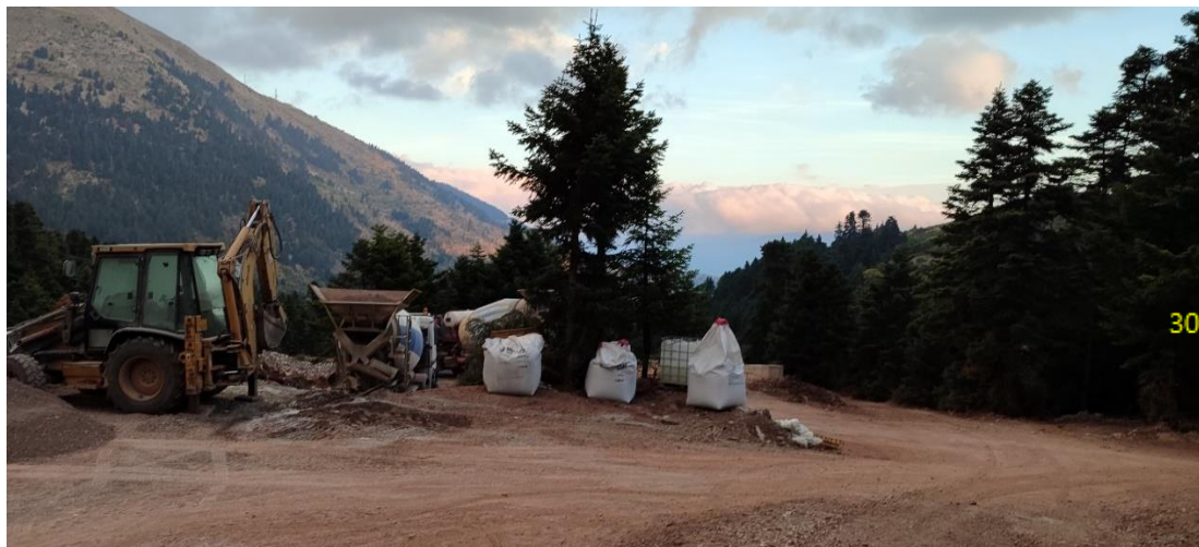
Εικόνα 4.2.18. Τεχνικά έργα δίπλα στο Δένδρο 30 (φωτ. Μάντζαρη Ελένη)
