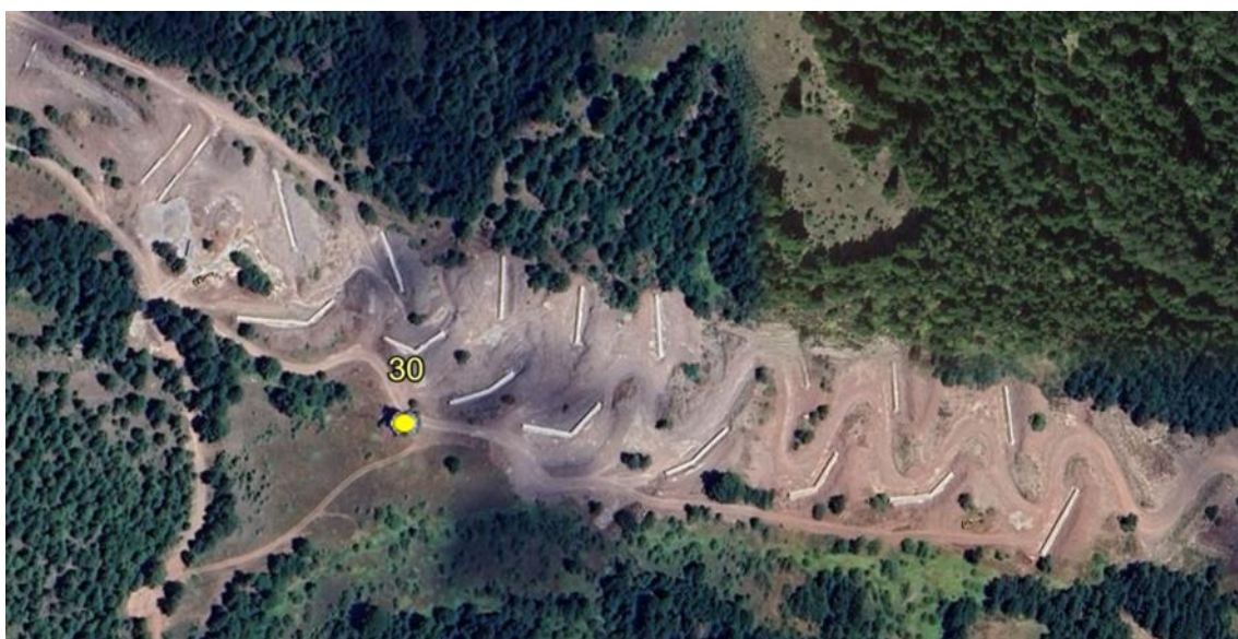
Εικόνα 4.2.19. Τεχνικά αντιπλημμυρικά έργα στη θέση Ιτιά, Δένδρο 30 (Πηγή: Google Earth)
