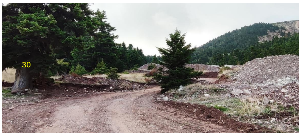
Εικόνα 4.2.17. Τεχνικά έργα διευθέτησης της ρέματος δίπλα στο Δένδρο 30 (φωτ. Μάντζαρη Ελένη)
