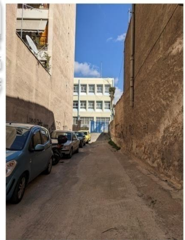
Άνοιγμα επί της Αυλώνας μεταξύ Γ. ΔΕΛΗ και Καλαμά
