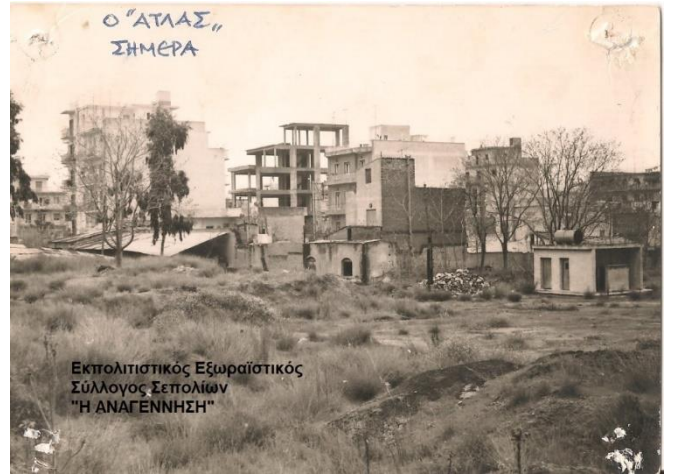
Εικώνα 36 Άποψη του Άτλα μετά την κατεδάφισή του, Φωτογραφικό υλικό Συλλόγου Αναγέννησης
