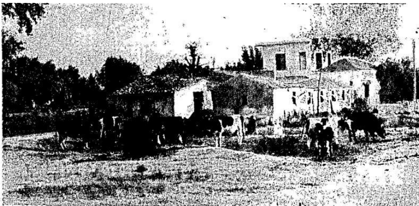
Δεν είναι πολύ παλιό ή φωτογραφία μας. Πριν μερικά χρόνια τα περισσότερα δω- στάσια είχαν στην διάθεσή τους τέτοια .. μεγάλα κτιριακά συγκροτήματα. Για ό- ρους υγιεινής δεν γινόταν κανένα. Σήμερα τέτοια δείγματα... ερημώθηκαν... ερημώ- δοτραφισα, υπάρχουν ελάχιστα. Και η προσπίδη είναι μία και μόνη. Να μην υπάρχει μέχρι τις αρχές του 1966 κανένα.
