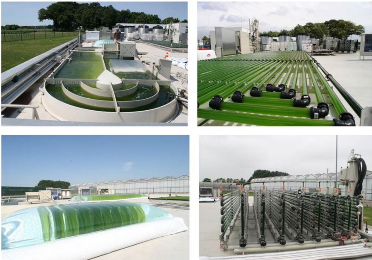
Εικόνα 2 Φωτοβιοαντιδραστήρες ανοιχτού και κλειστού τύπου, σε λειτουργία, στις εγκαταστάσεις του AlgaePARC, Ολλανδία (de Vree et al., 2015).
