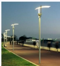
Φωτιστικά ανακλώμενου φωτισμού
