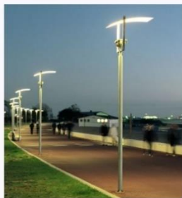
Φωτιστικά ανακλόμενου φωτισμού
