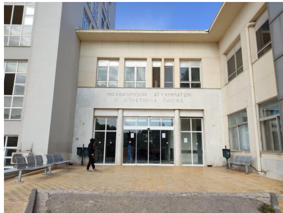
Εικόνα 37: Ανατολική είσοδος κτιρίου νοσοκομείου ΚΑΤ. Διακρίνεται ειδική πλακόστρωση και αστικός εξοπλισμός. Φωτογραφία 17.10.2023
