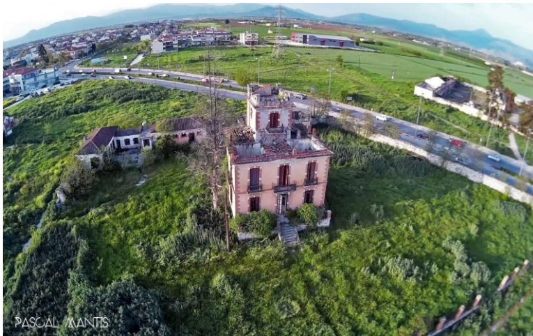
Εικόνα 12 : Πύργος Χαροκόπου και στο βάθος η περιοχή της Γιάννουλης
