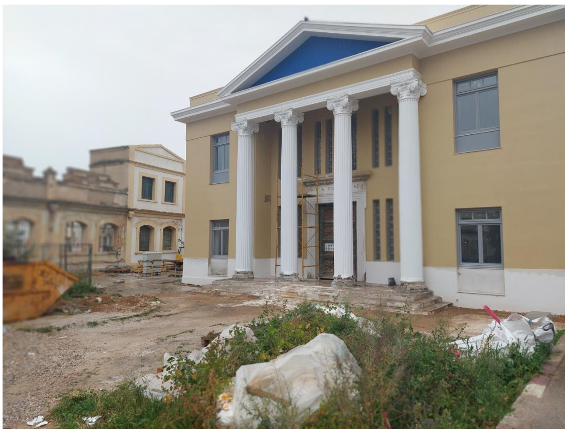
Εικ. 1. Το κτίριο διοίκησης όπως ανακαινίζεται στην παρούσα φάση
