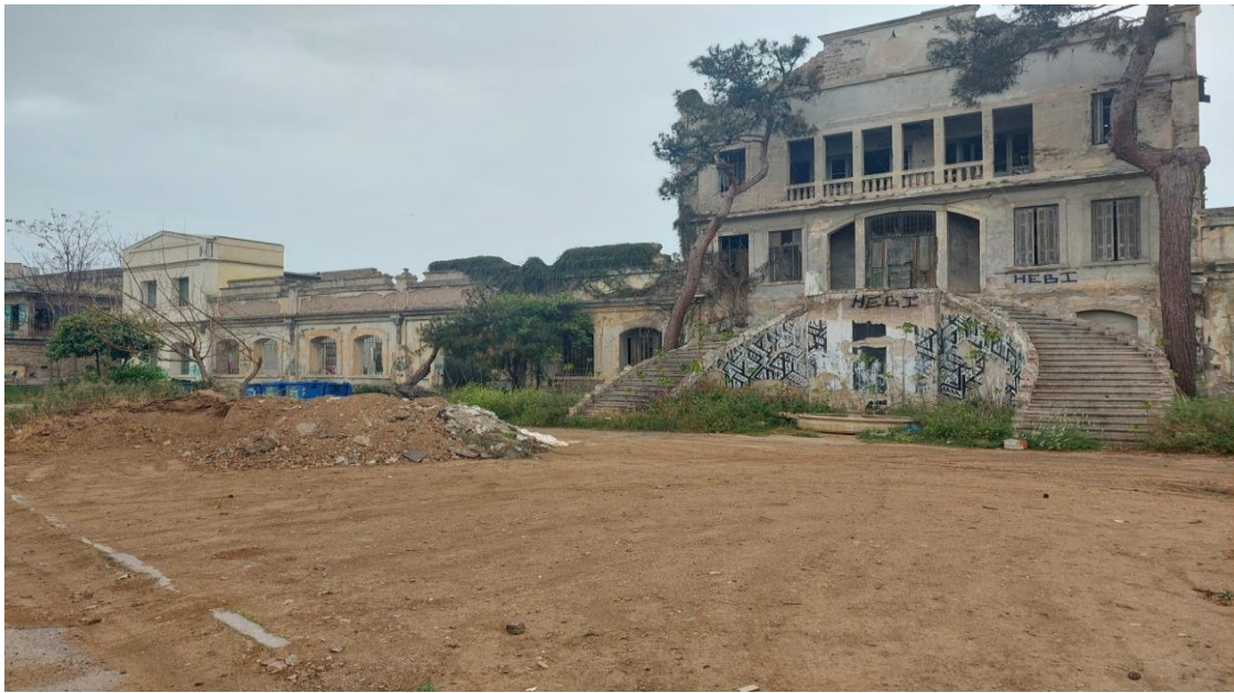
Εικ. 5. Η χαρακτηριστική εναπομείνασα πρόσοψη (façade) του βιομηχανικού κατάλοιπου της εριουργίας
