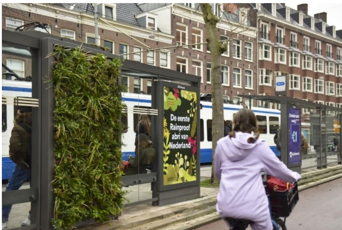
Εικόνα 4. Αυτοποτιζόμενος πράσινος τοίχος με σύστημα αποθήκευσης βρόχινου νερού σε στάση τραμ, Άμστερνταμ, Ολλανδία
