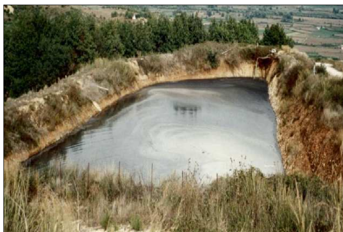
Εικόνα I.3 Ανοιχτή χωμάτινη δεξαμενή αναερόβιας επεξεργασίας υγρών μηχανικού διαχωρισμού αποβλήτων χοιροστασίου (περιοχή Τανάγρας)
