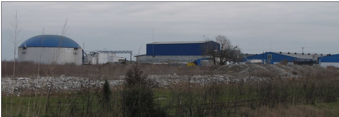
Εικόνα I.4 Χοιροστάσιο στην Βέροια με εγκατάσταση αναερόβιας επεξεργασίας των αποβλήτων με ταυτόχρονη παραγωγή βιοαερίου
