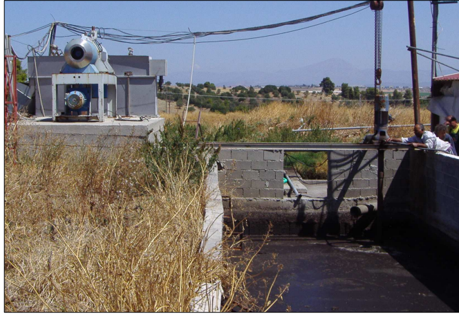
Εικόνα I.1 Μηχανικός διαχωριστής (αριστερά) και δεξαμενή υποδοχής υγρού κλάσματος αποβλήτων χοιροστασίου(δεξιά) (περιοχή Τανάγρας)
